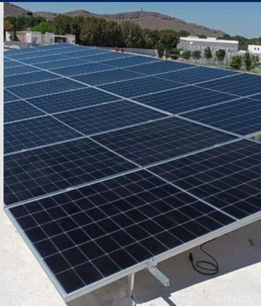
**PENSSO** diseñó e instaló un sistema fotovoltaico compuesto por **25 paneles** solares de **665W**, optimizando la generación de energía para cubrir la mayor parte del consumo eléctrico diurno.
