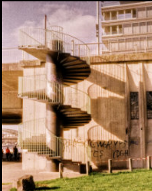
dreiundzwanzig/2026...schnell rauf zur Brücke und rüber, solange sie noch hält
