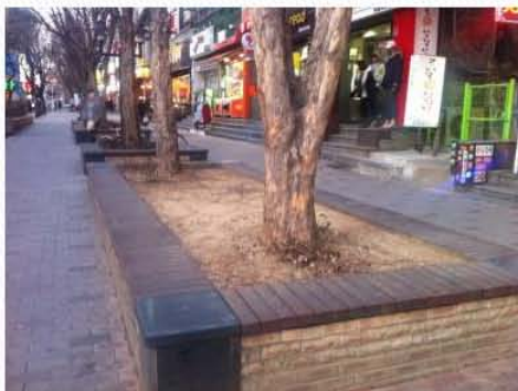
Trước khi thi công sau Emart, Godeokdong, Gangdong-du
