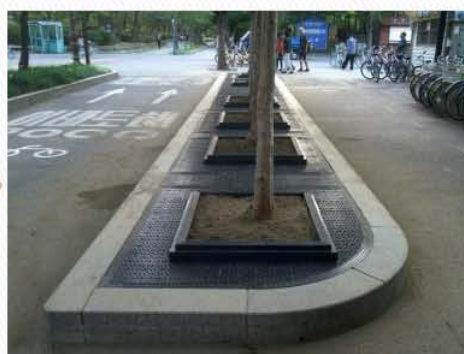
Sau khi thi công
