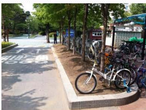
Trước khi thi công
