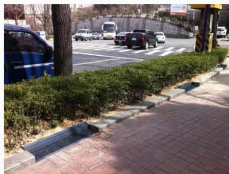
Thi công thêm thiết bị thoát nước mưa ở trước Ambassador Hotel
