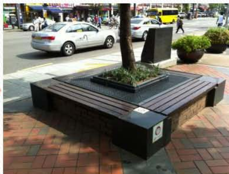
Sau khi thi công
