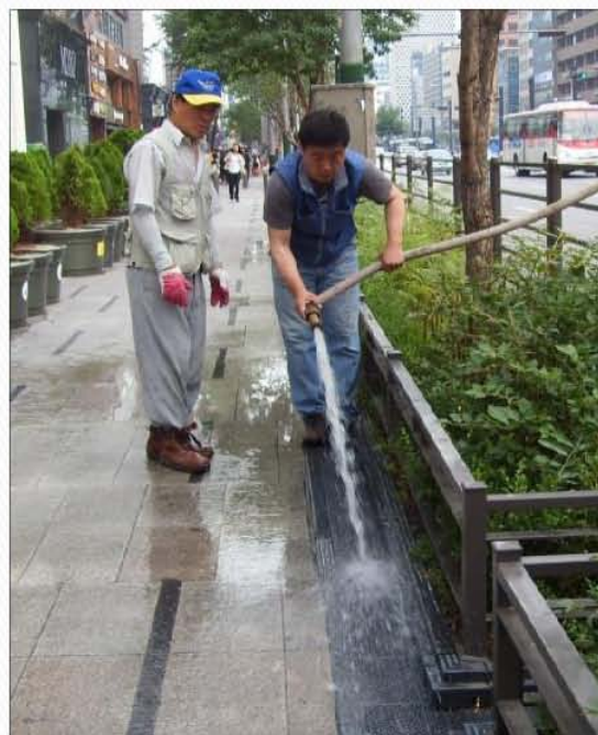
Sau khi thi công: ngăn sự lãng phí nước, tránh cát đất văng ra ngoài, cung cấp nước hiệu quả và nhanh chóng
