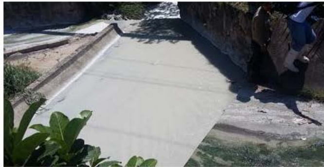
Imagen 1: Vista de la Canaleta de Descarga Externa. El vertido se observa totalmente blanco
