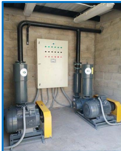
Imagen 11: Blowers PTAR AIES 2019, 25 hp 3 lóbulos, Ruido: 90 dba
