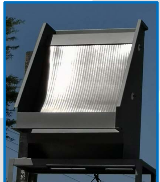
Imagen 12: Filtro Fino Autolimpiable Tipo Tobogán, PTAR AIES 2019, 300 gpm
