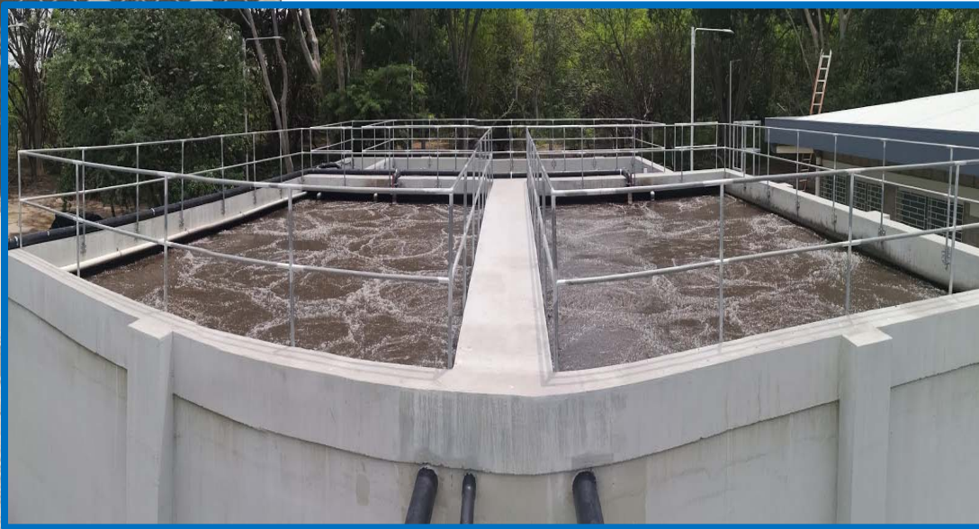
Imagen 7: Planta de Tratamiento Aguas Residuales Aeropuerto Monseñor Romero, Lodos Activados con Aireación Extendida, 2019, 600 m 3 /d
