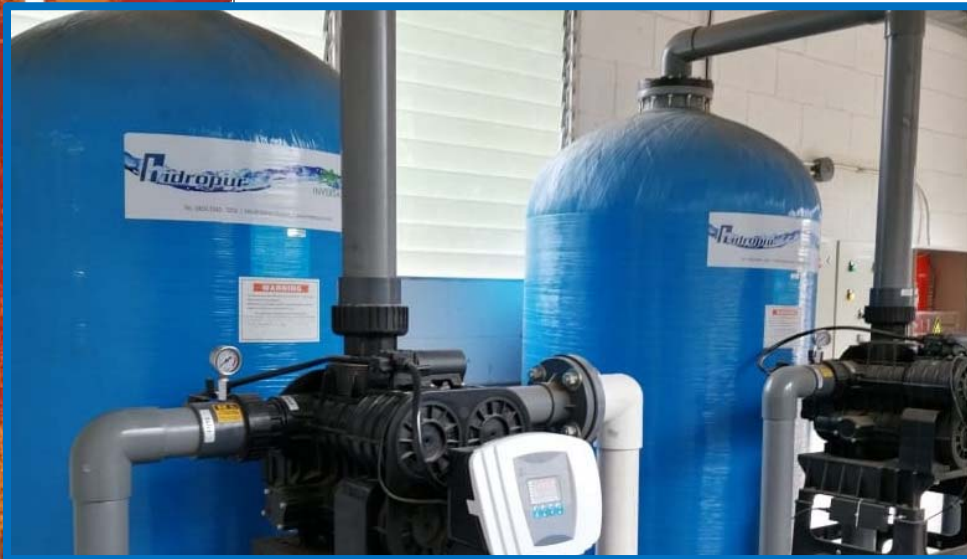
Imagen 4: Filtros para remoción de Manganeseo, CIFA 2019, 145 GPM
