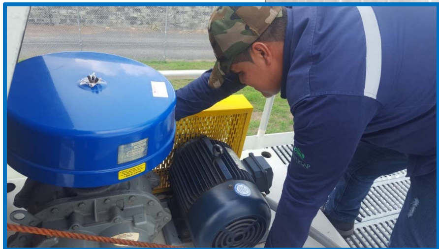
Imagen 13: Dando Mantenimiento a Blowers 15 hp
