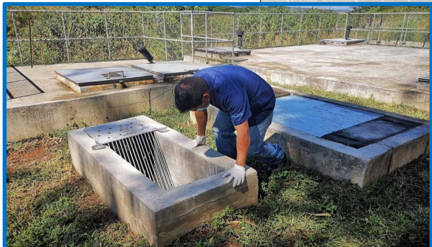
Imagen 14: Dando Mantenimiento PTAR Hospital Nacional de La Unión
