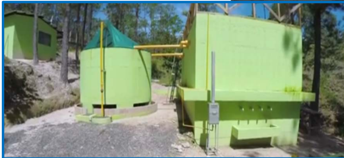
Imagen 8: Planta de Tratamiento Aguas Residuales Municipales, Parquin, Morazán, 2017, UASB + Filtro Percolador 150 m 3 /d
