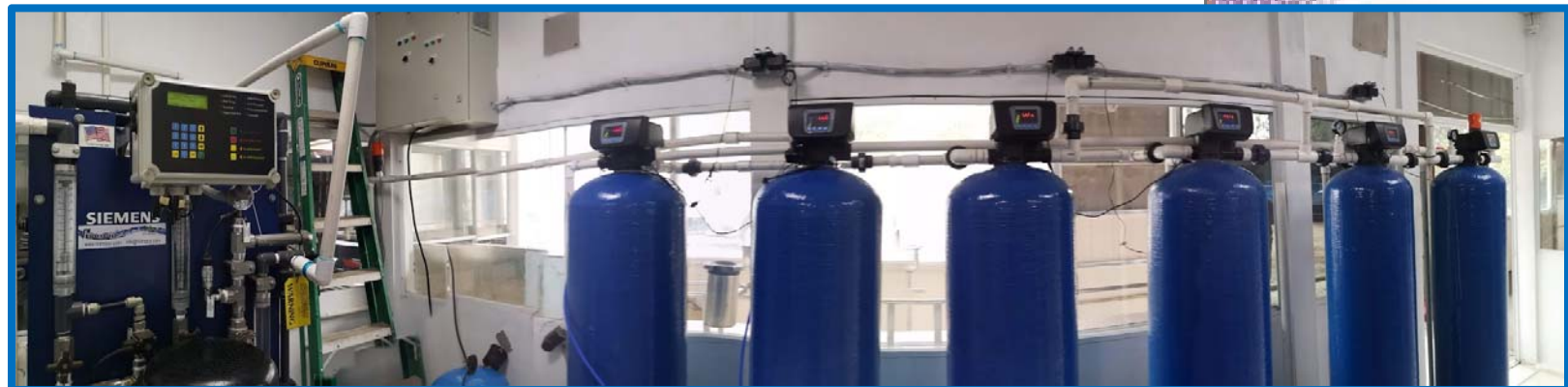
Imagen 5: Planta de Potabilización Basada en Osmosis Inversa Crystalline, 15 gpm
