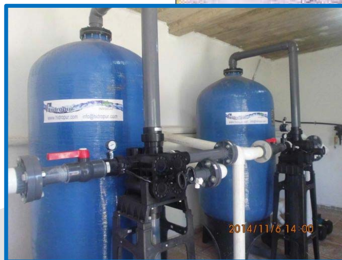
Imagen 6: Planta de Potabilización Municipal PERQUIN, Aguas Superficiales, 150 gpm
