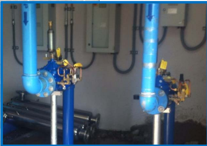
Imagen 9: Válvulas Anticipadoras de Golpe de Ariete para el Nuevo Hospital de la Mujer, 2018
