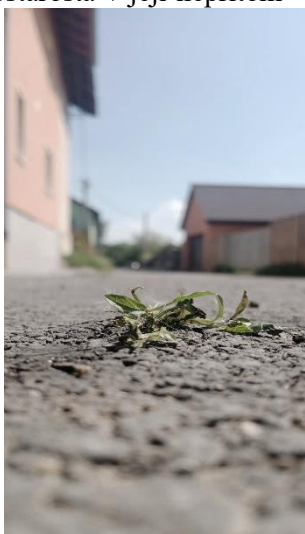
V asfaltu rašící flóra na nově zrekonstruované ulici na Horním Brandyšku
