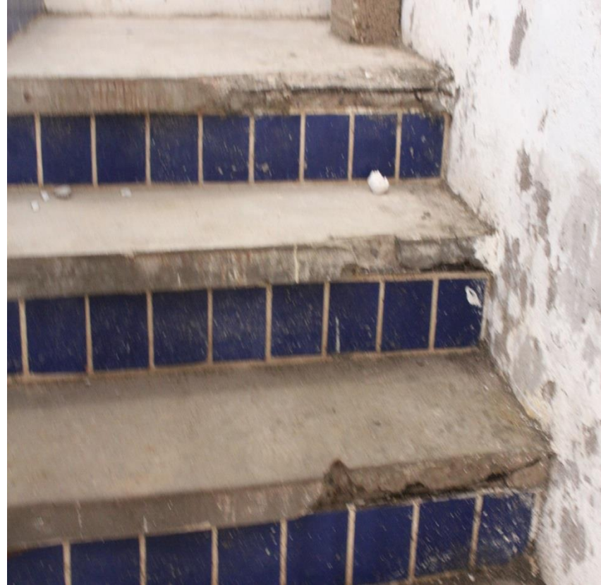
ESCALERAS ACCESO 2 PISO
