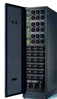
ARCHIMOD HE modulares de 20 kVA a 120 kVA
