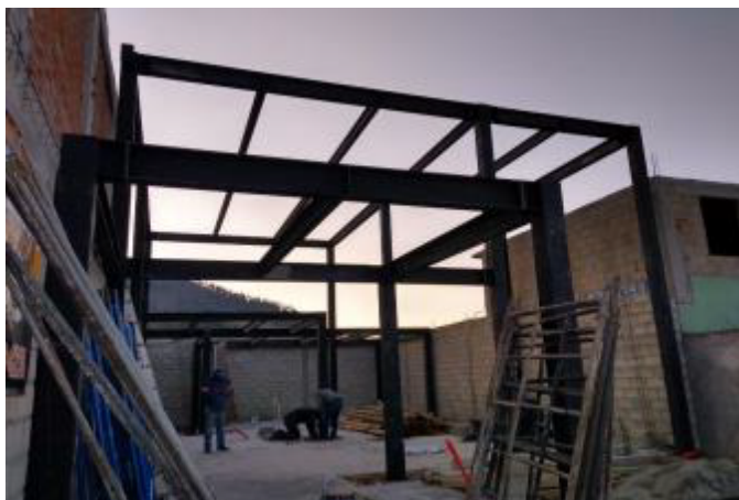
Diseño, fabricación y montaje de estructuras
