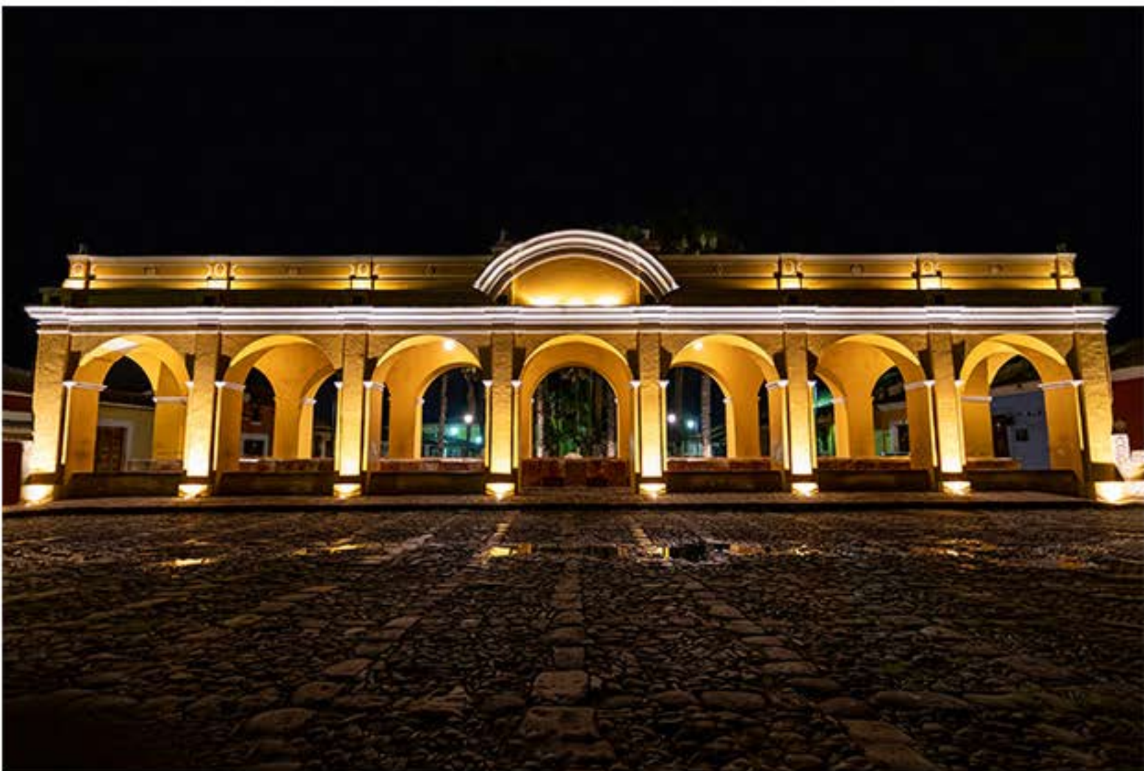
Tanque La Unión
