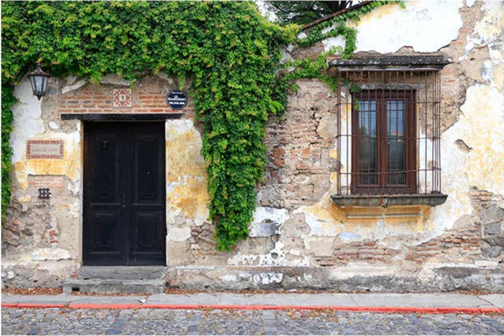
Fachada Calle de Los Pasos A193
