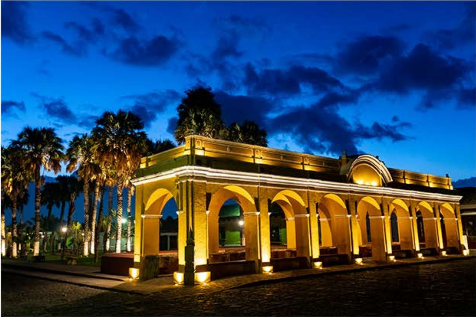
Tanque La Unión
