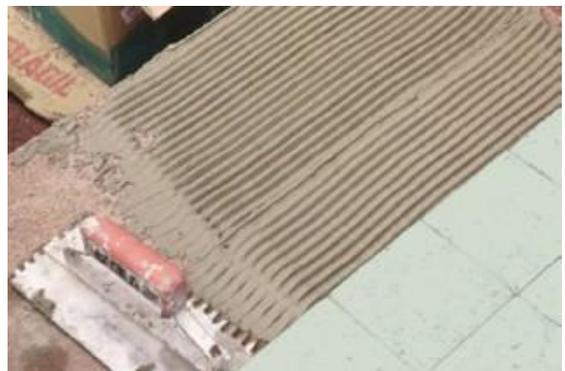
capa de 4 mm de espesor. Luego, pase la parte dentada de la llana con un ángulo de 60° en una sola dirección, formando esquinas uniformes de adhesivo
