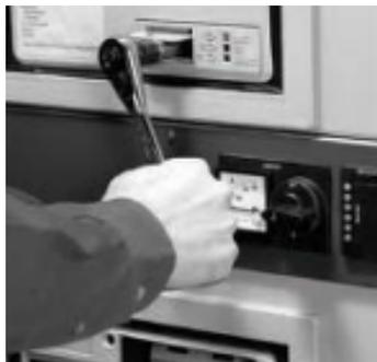
La palanca del disyuntor extraíble puede ser Realizado con el compartimento Puerta cerrada sin necesidad de Herramienta de palanca especial
