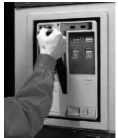
Diseño a través de la puerta para humanos Interfaz con el disyuntor Puerta del compartimento cerrada, por ejemplo, Carga manual de lo almacenado Manantiales energéticos
