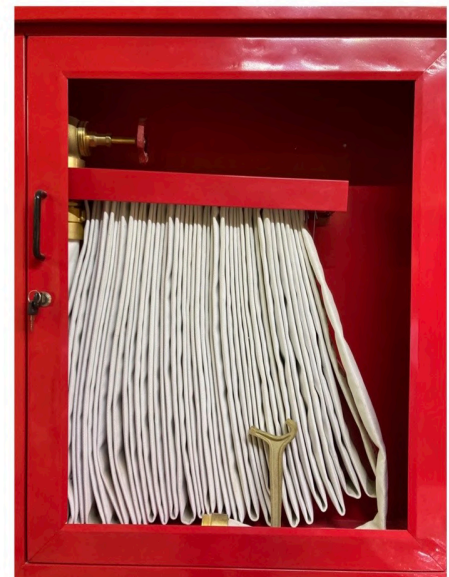
Modelo 410 Hidrante completo: manguera válvula, chiflon, llave, gabinete y soporte
