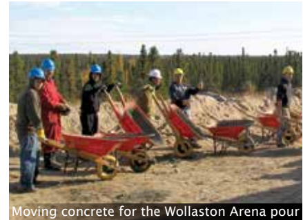
Moving concrete for the Wollaston Arena pour
