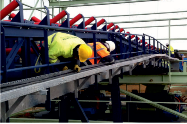
Kablo Çekim İşlemi
