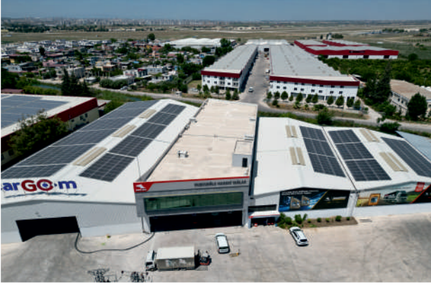
Kuşcuoğlu GES / 900kWp
