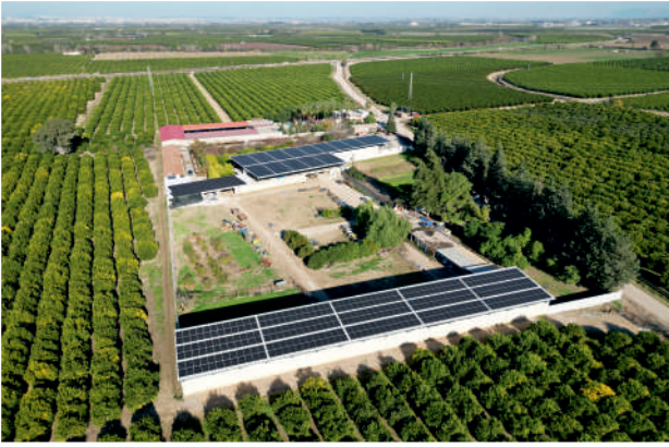
Ramazanoğlu GES / 1,8MW
