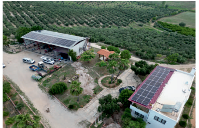
Ales Tarım GES / 450kWp
