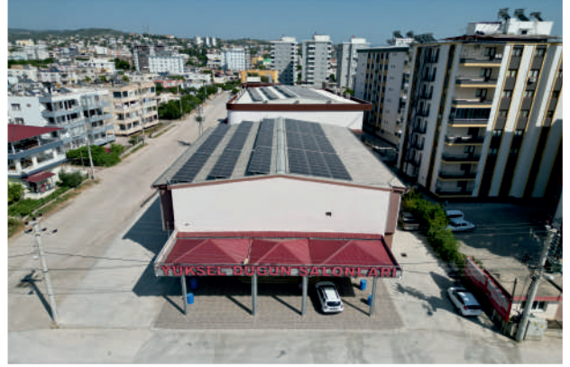
Yüksel 2 SPP / 820kWp
