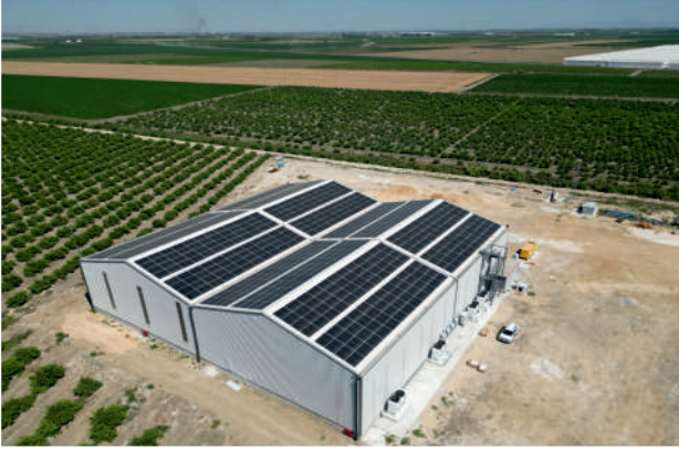
Ölke SPP / 401,12kWp
