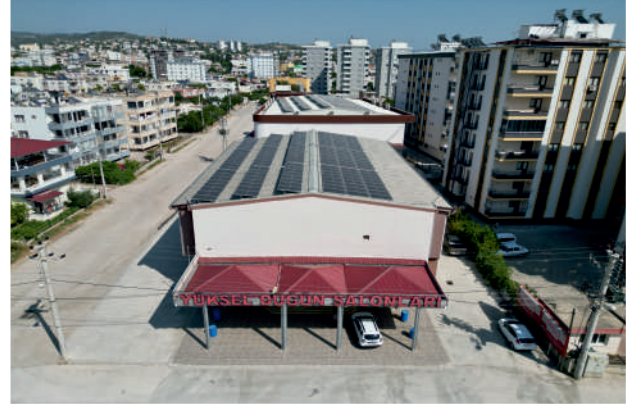
Yüksel 2 GES / 180,39 kWp
