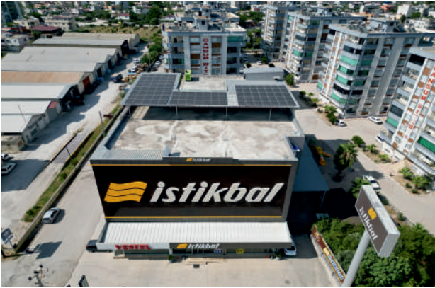
Yüksel 3 GES / 52,32kWp
