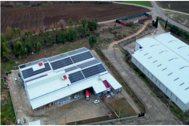
Multisistem GES / 308kWp
