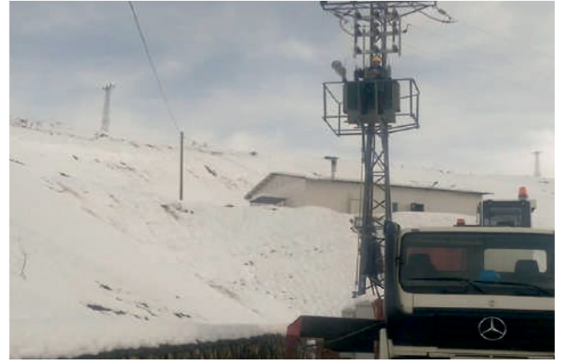
Direk Üstü Trafo Montajı
