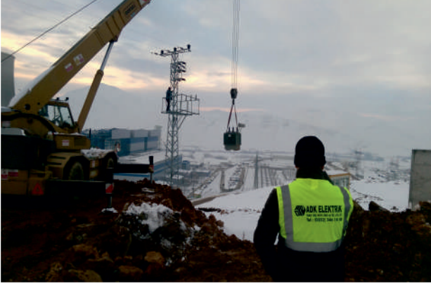
Direk Üstü Trafo Montajı
