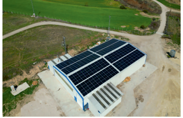
Tayftar Tarım GES / 1.85MW
