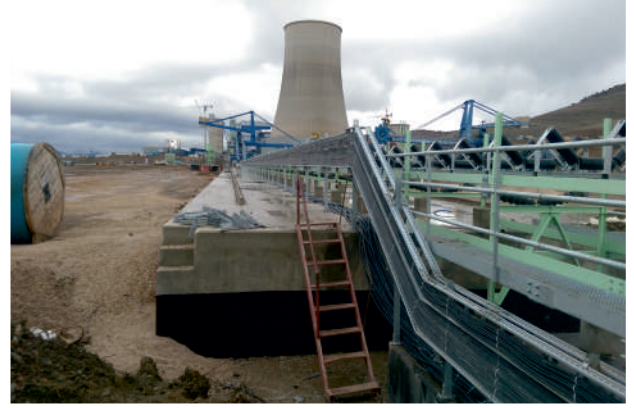
Motor Bağlantı Kablosu Reglajı
