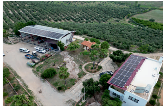
Ales Tarım GES / 50,5kWp
