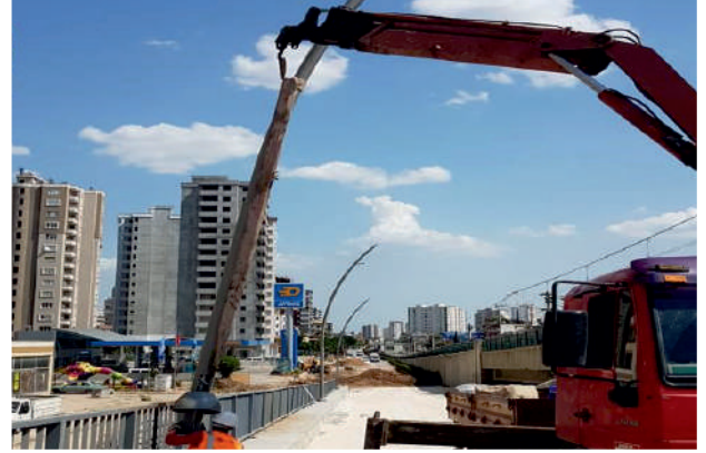
İkizler Köprüsü Aydınlatma Sistemleri
