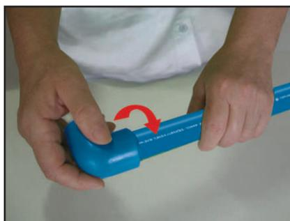
**07** Por 3 segundos ainda é possível ajustar o posicionamento da conexão, com um giro máximo de mais ou menos 15°;
