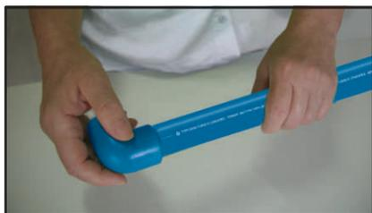
**06** Introduzir o tubo imediatamente na conexão de forma contínua até o batente;
