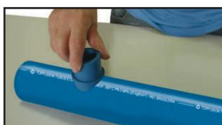
**06** Pressione firme a derivação, verificando sua perpendicularidade com o tubo. É importante que a derivação seja pressionada ao tubo por aproximadamente 1 minuto;
