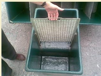
DIGESTOR DE GRASAS
