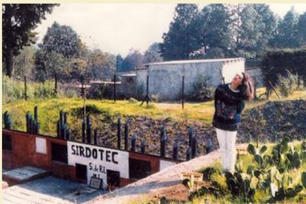
Tres Mariás, 1988. La CB dependía de Lodos generados en el Tanque de Aguas negras.
