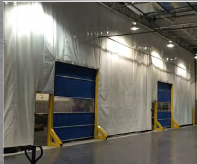
CONTROL DE TEMPERATURA
