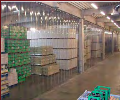
CONTROL DE TEMPERATURA
