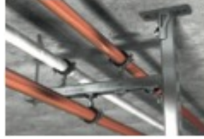
Dikme profil ile yapılan support
