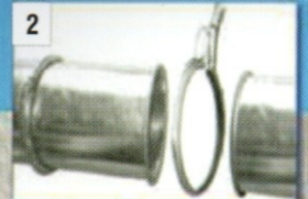
Kanalların Kenetlenmesi
