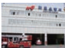
소방서 fire station
