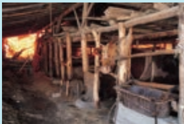
축사 cowshed/pigsty 축사 지붕을 점검하거나 수리합니다. Check and repair the roof of a cowshed or a pigsty.
