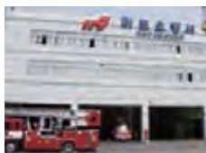
소방서 fire station
