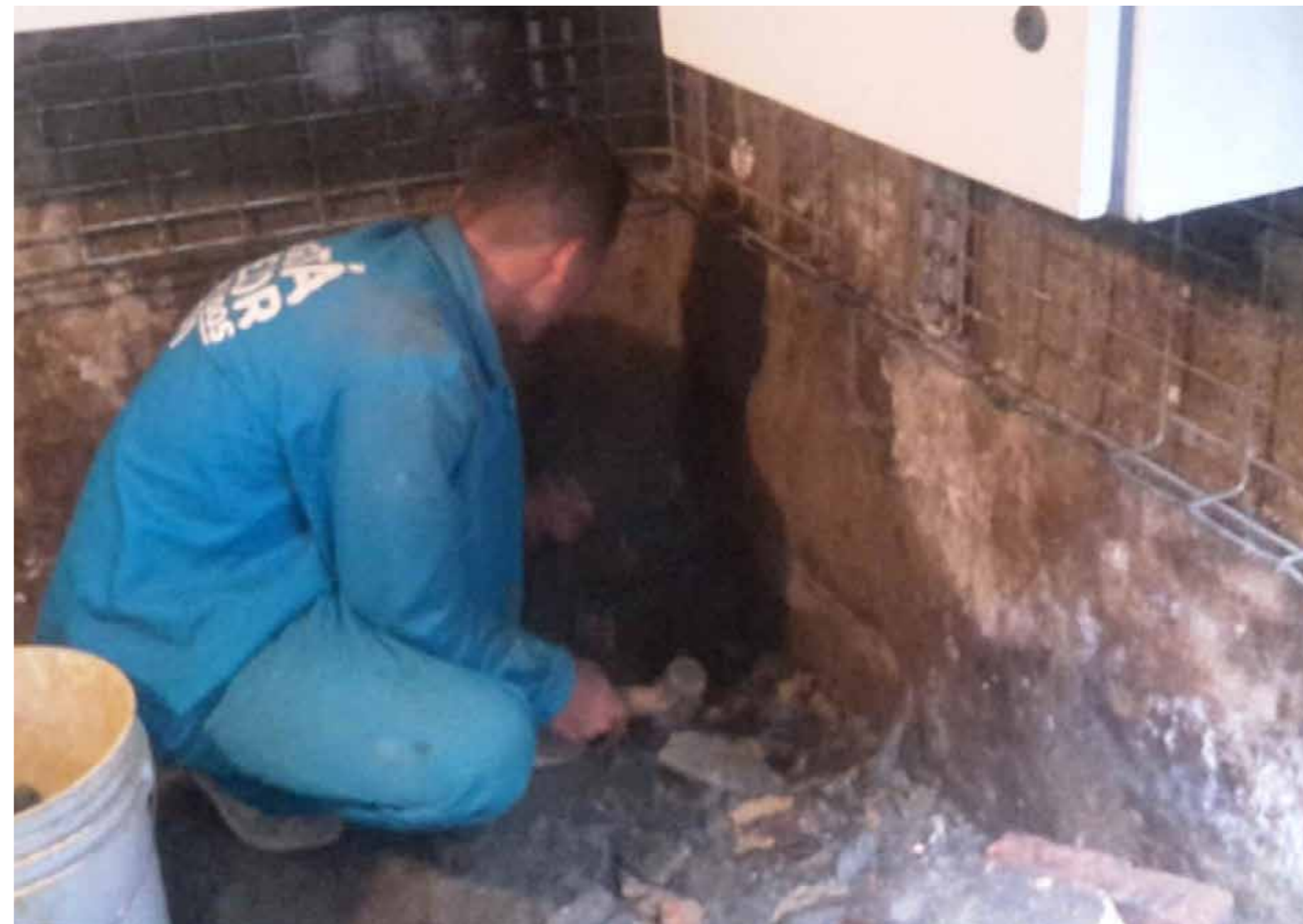
Mantenimiento del bunker - instalación baldosin
