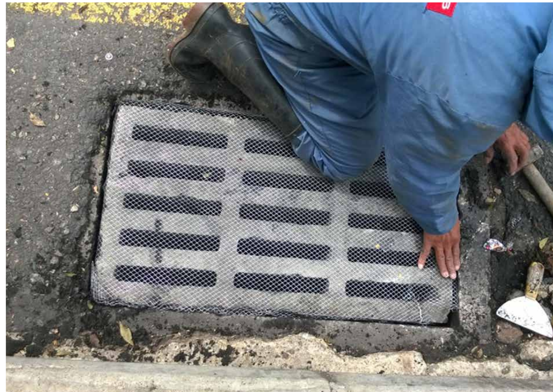
Instalación de mallas y cebos contra roedores
