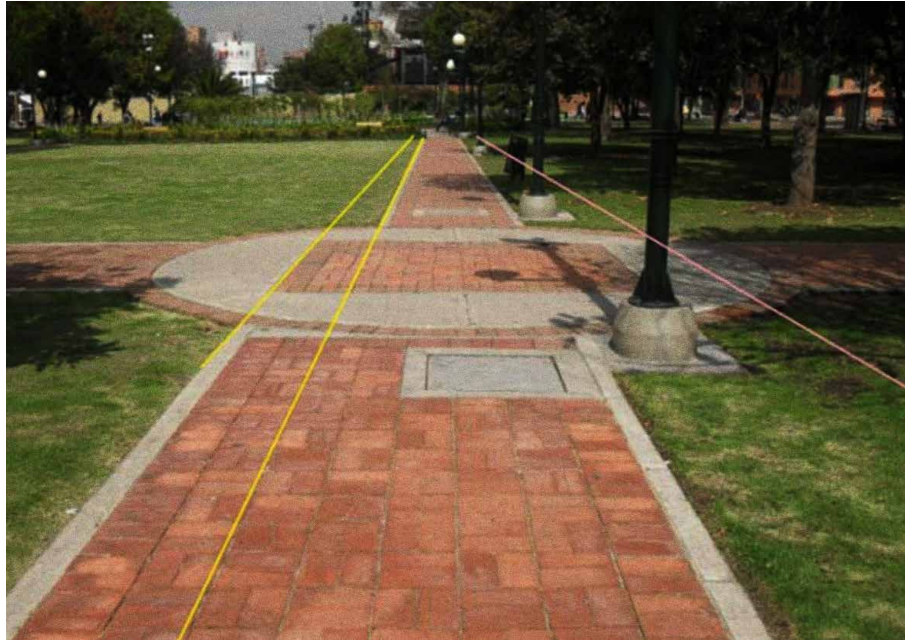
Falta de diseño en caminos peatonales
