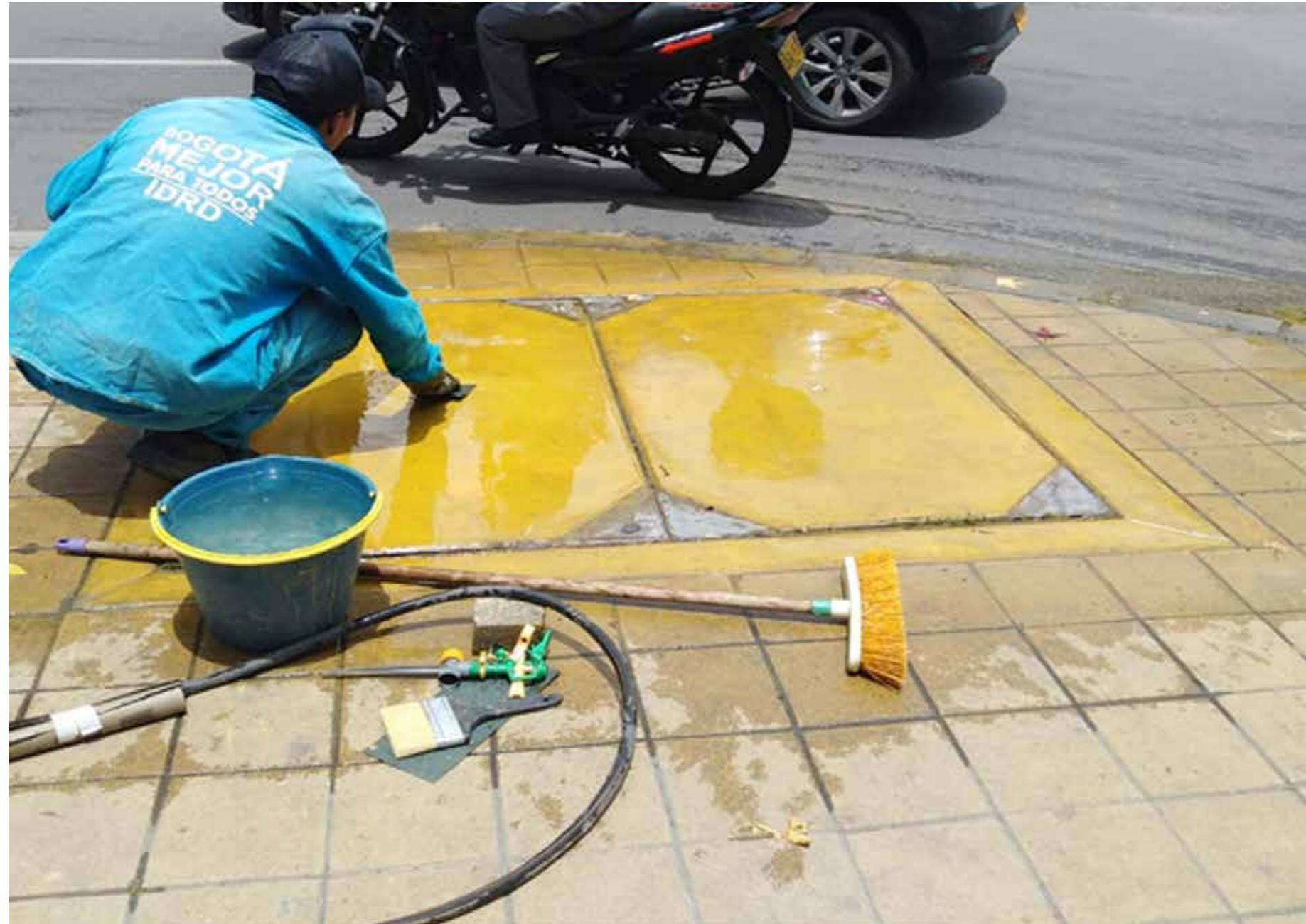
Mantenimiento zonas duras adoquín, tapas y bunker
