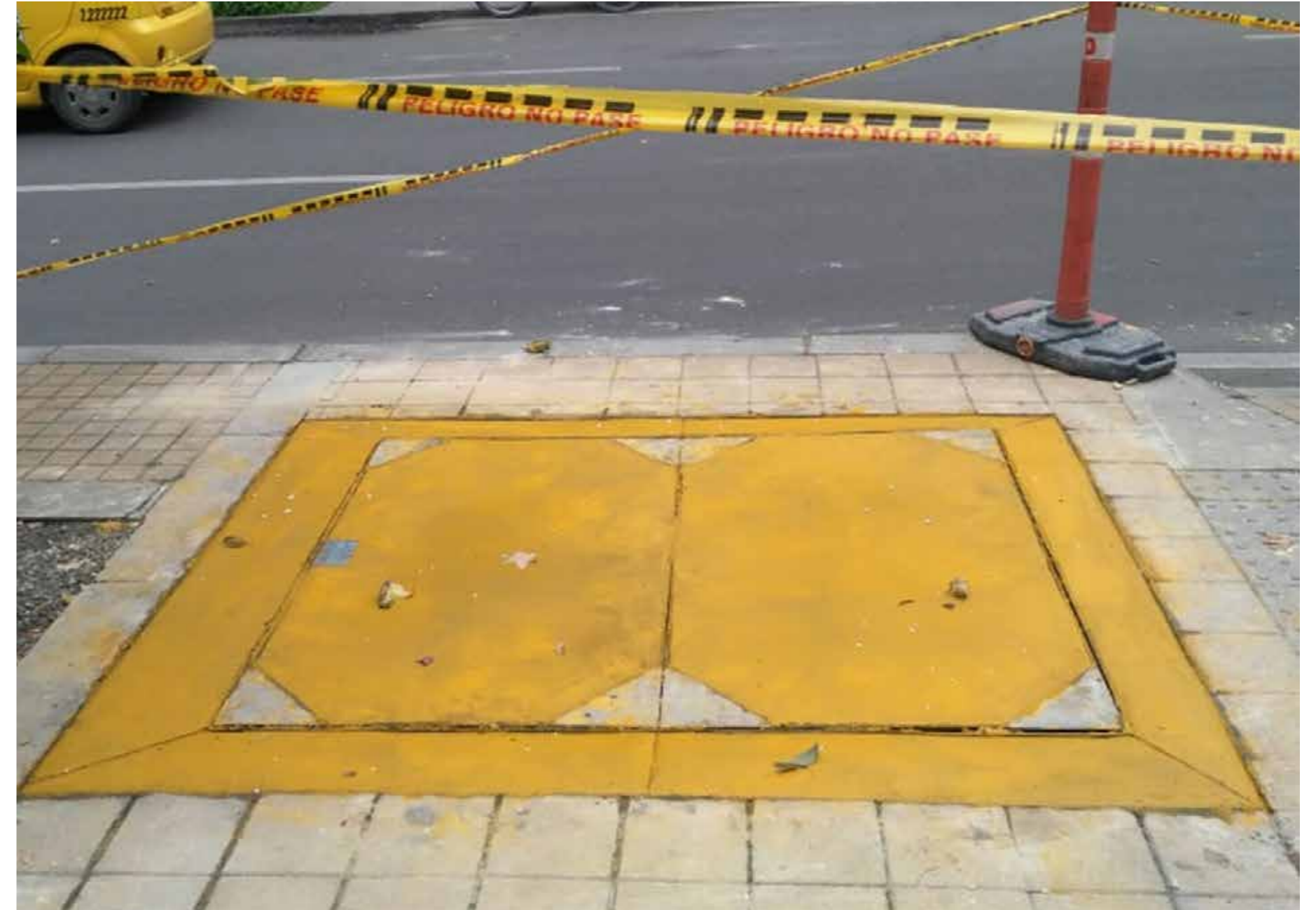
Arreglo tapas (demolición y fundición)
