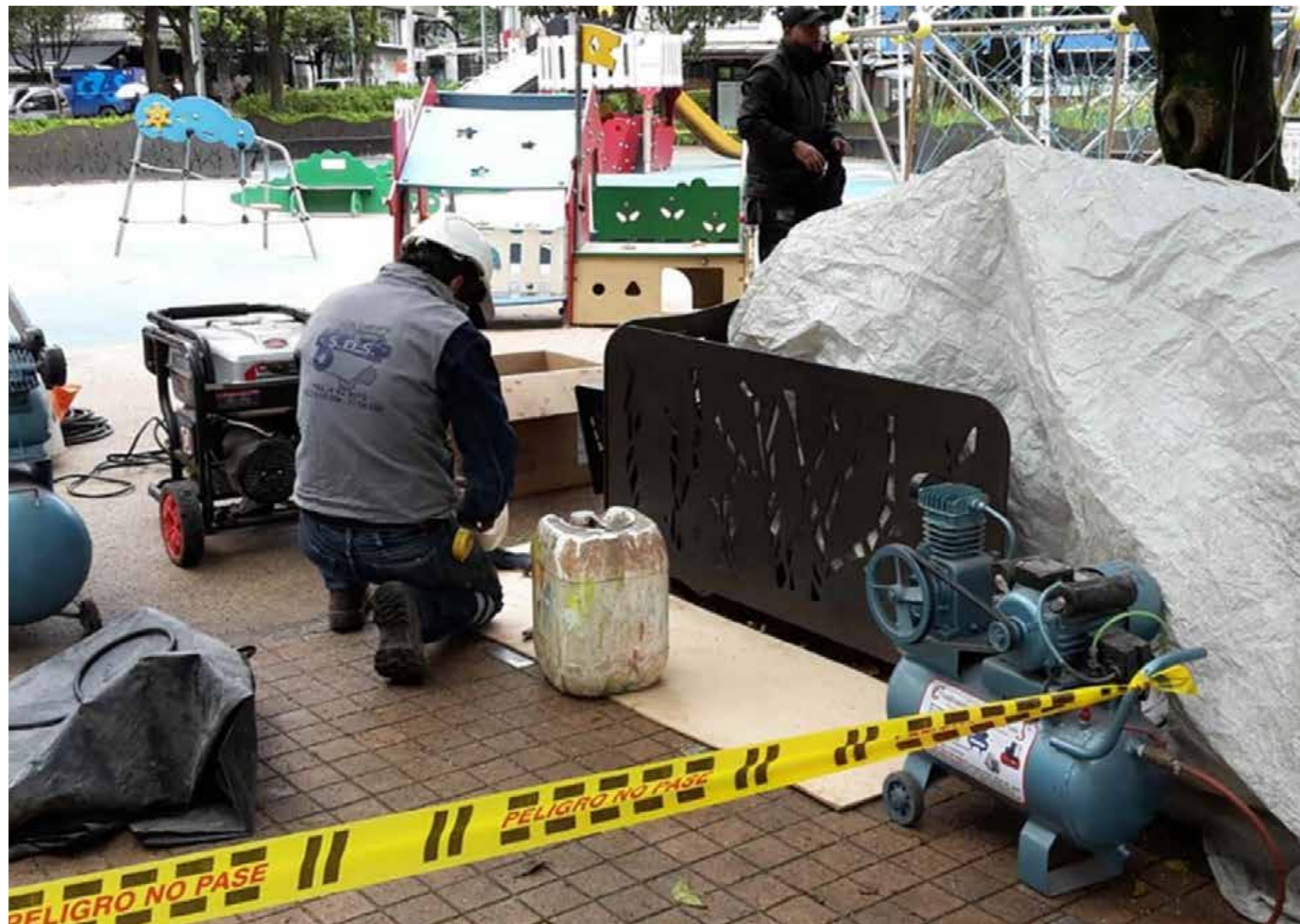
Mantenimiento de pintura banca lineal zona infantil
