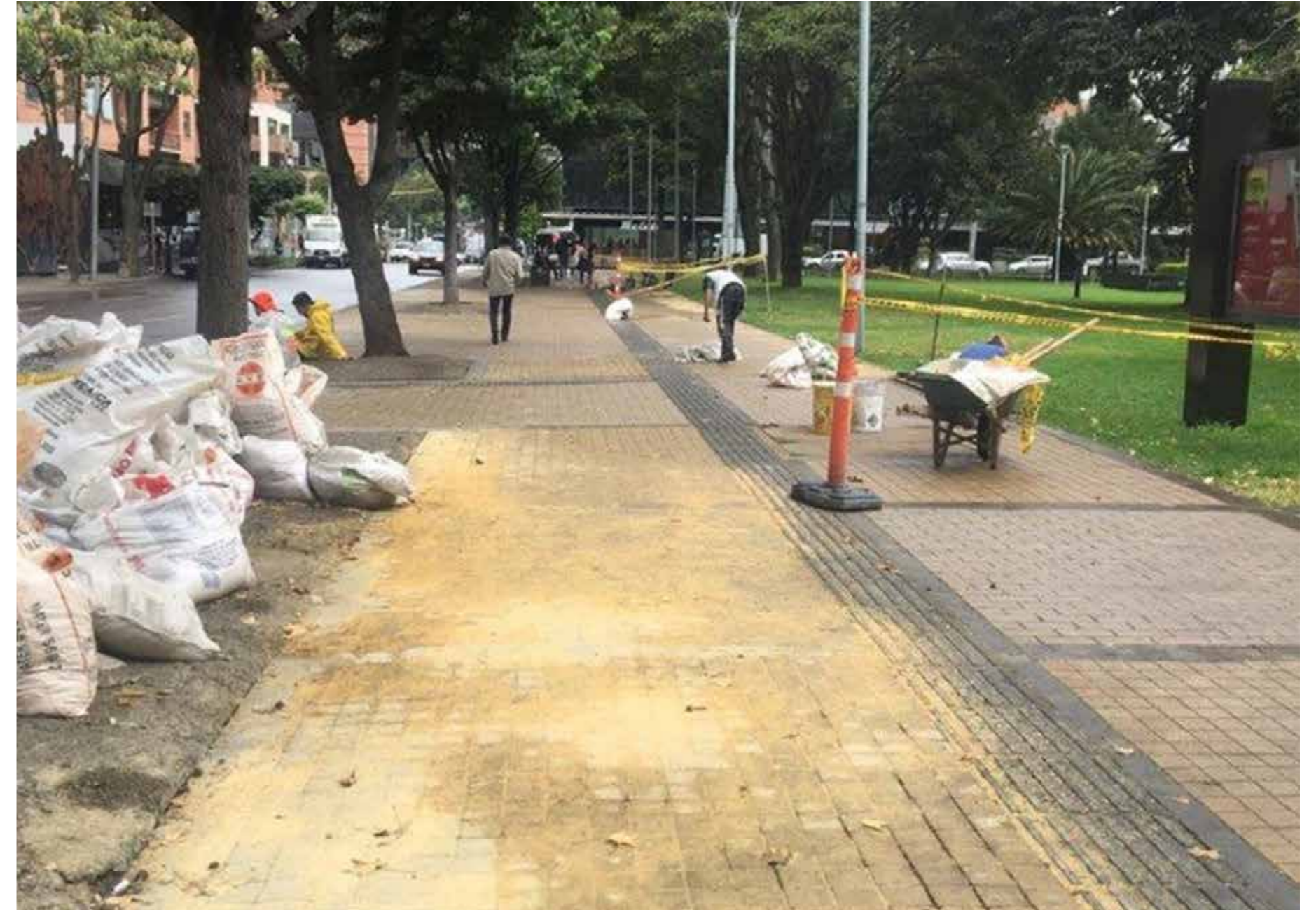
Arreglo de bordillos
