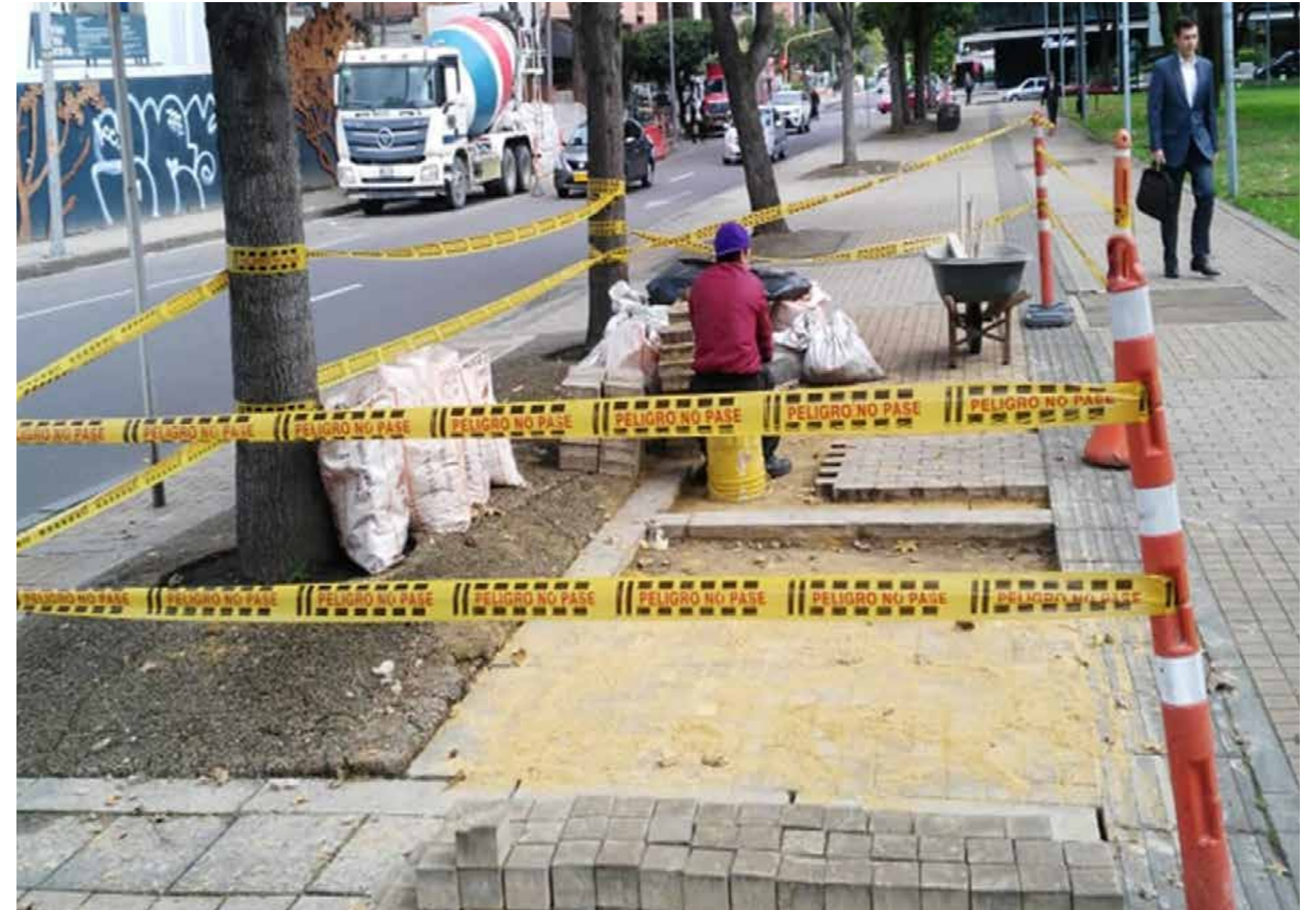
Mantenimiento zonas duras adoquín, tapas y bunker
