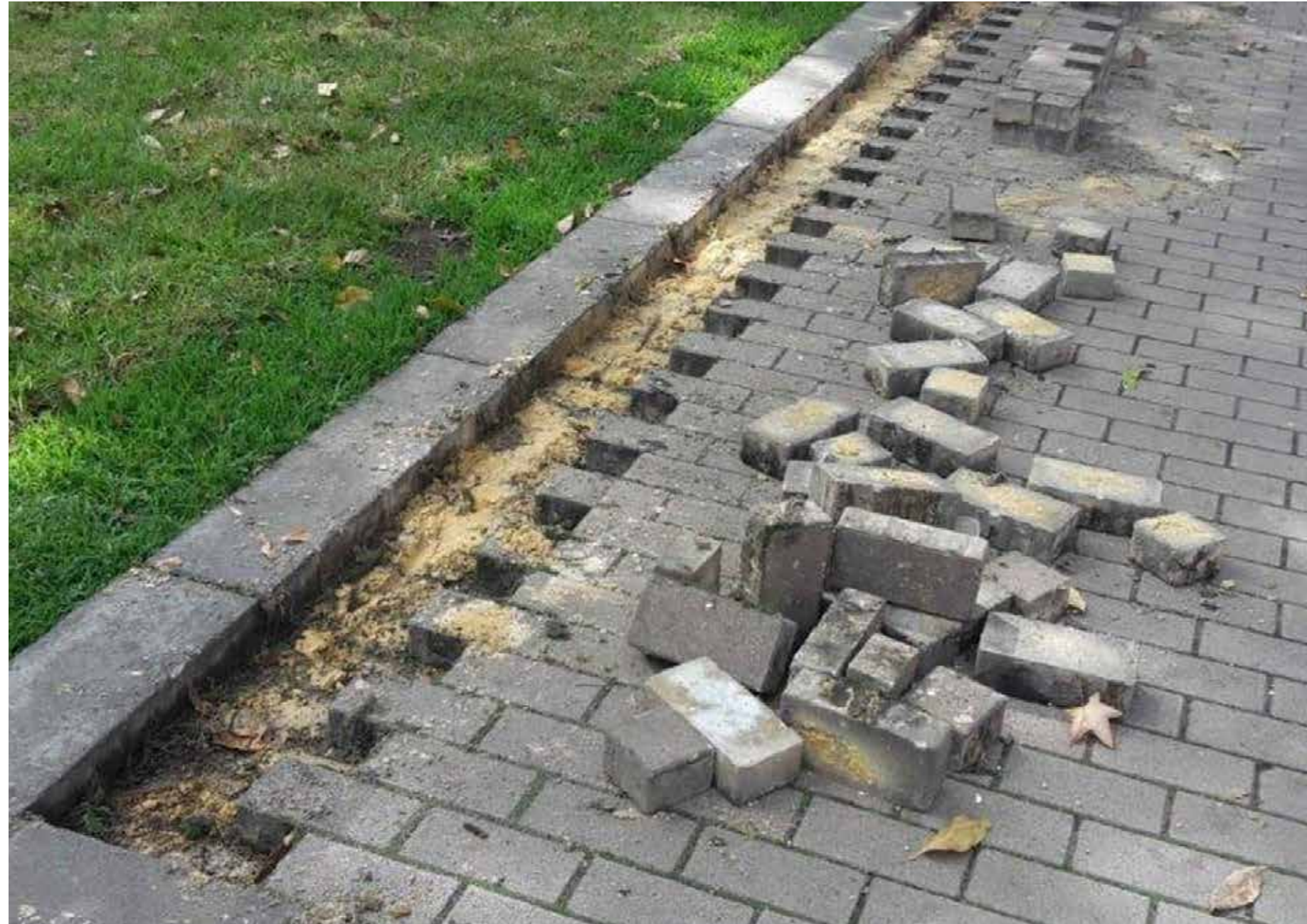
Arreglo de bordillos
