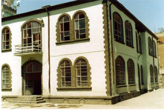
Şekil 14. Yapının Güney Cephesi ( Baydaş, 2007)
