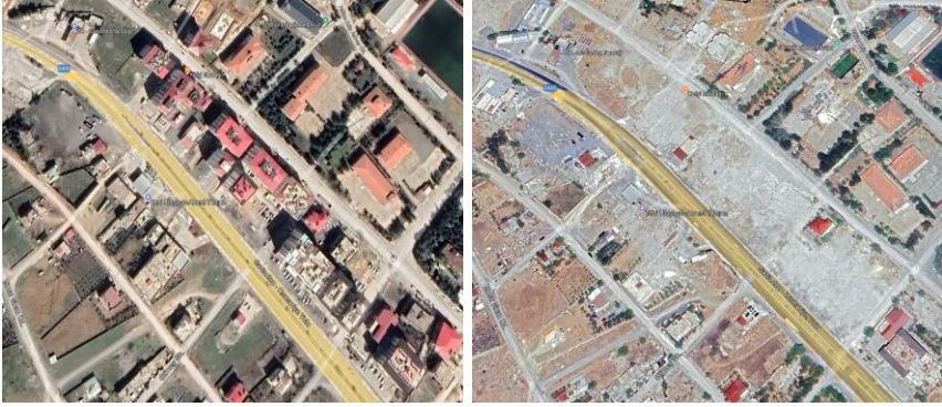
Şekil 11. a) Deprem öncesi 8 katlı b) Deprem Sonrası Yıkılmış Haliyapılar
