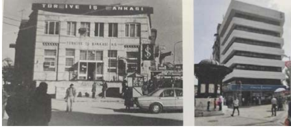
Şekil 12. Arif Hikmet Holtay tasarımı İş Bankası Malatya Şubesi ve günümüzde yerinde bulunan şube (Kaynak: Özen Bilgin, 2024).
