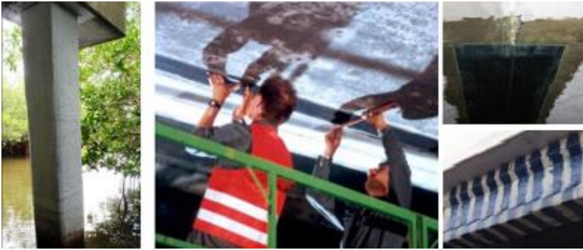
Şekil 3. Betonarme yapılarda FRP kaplama uygulamaları (Ahmed, 2025)
