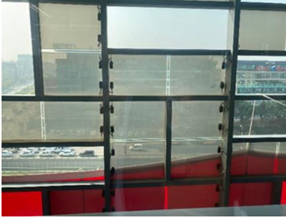
Şekil 15. Bursagaz Binası Cephe Sistemi (Orijinal, 2023)
