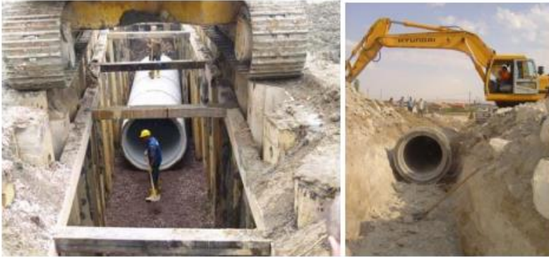
Şekil 1. Atıksu Borularının Döşenmesi
