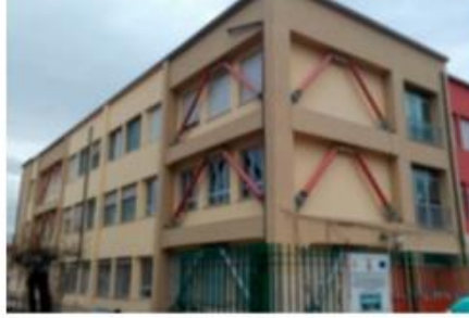
b. Güçlendirilmiş binanın dış görünüşü
