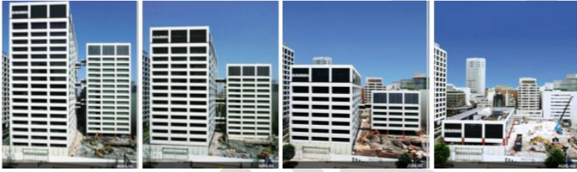
Şekil 7. Kajima yöntemi ile yıkım
