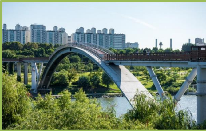
Şekil 4. Seonyu yaya köprüsü, Güney Kore (“ https://www.betonvecimento.com/beton-2/ultra-yuksek-performansli-beton/ ”, 2024)
