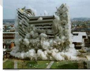
B) Patlayıcı ile kontrollü yıkım
