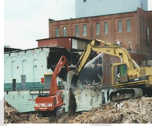
B) Makine ile Yıkım
