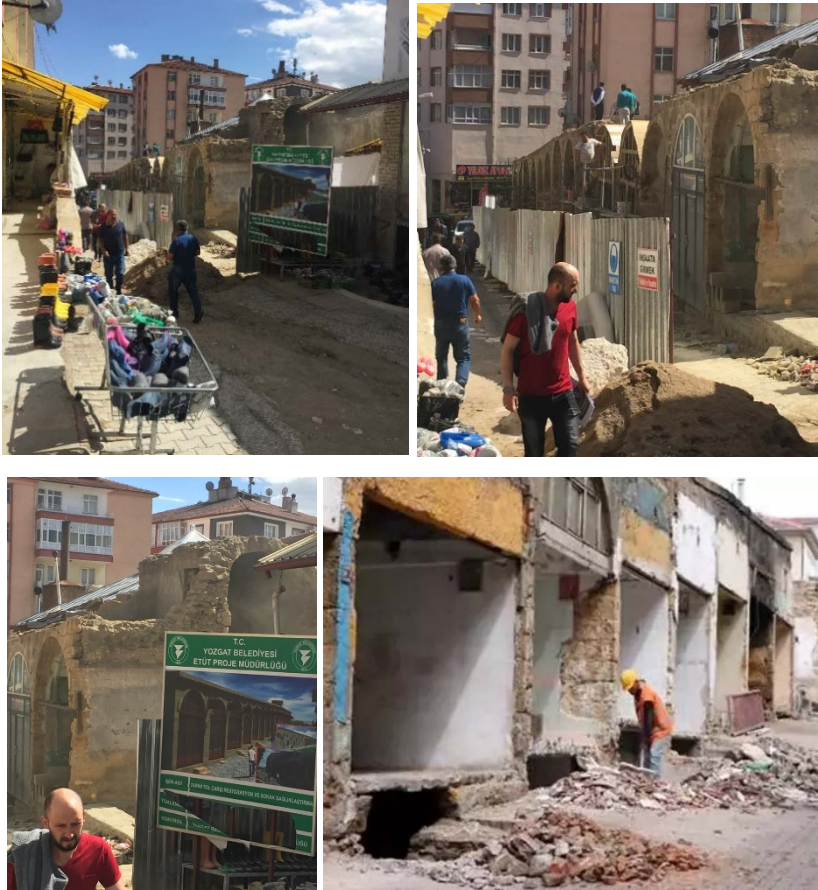
Şekil 6. Tol Çarşı Restorasyon Uygulaması (Yazar Arşivi; httpswww.milliyet.com.tr/yerel-haberler/yozyozgatin-tektarihi-carsisinde-calismalar-suruyor-12042823 )
