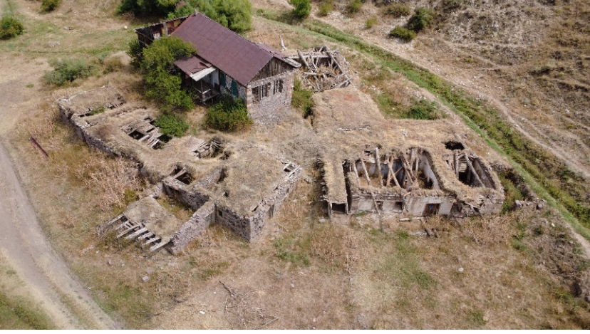
Şekil 1. Yerleşke genel görünüm (Şimşek Beyaz, 2025)
