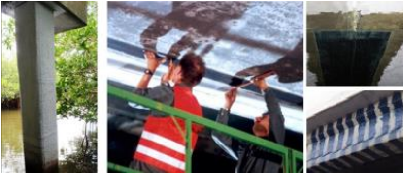
Şekil 3. Betonarme yapılarda FRP kaplama uygulamaları (Ahmed, 2025)
