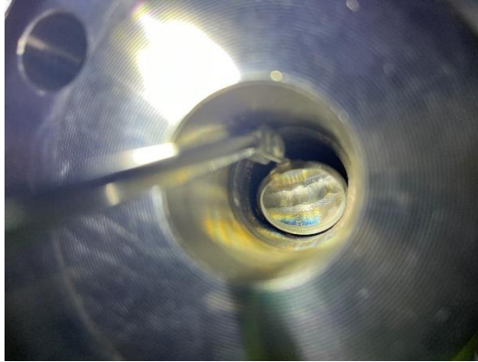
Şekil 2. Boru kök kaynağının ayna yardımı ile yapılan görsel kontrolü
