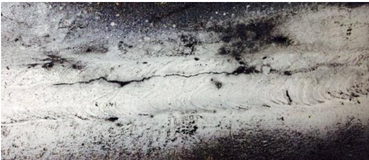
Şekil 6. Görünür manyetik paracak testi sırasında tespit edilen bir pasolar arası atlak.
