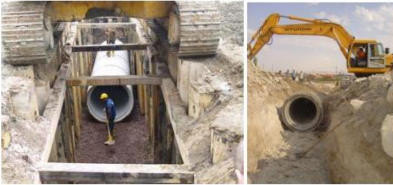
Şekil 1. Atıksu Borularının Döşenmesi
