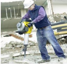
A) El ile Yıkım
