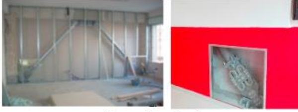
a. Çapraz sistemi ve damper
