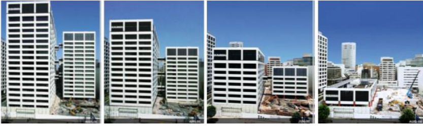
Şekil 7. Kajima yöntemi ile yıkım
