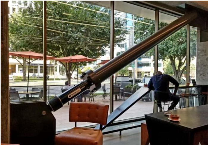
Şekil 2. Viskoz sıvı sönümleyici uygulaması
