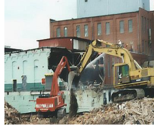
B) Makine ile Yıkım
