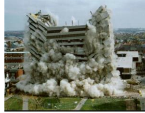
B) Patlayıcı ile kontrollü yıkım
