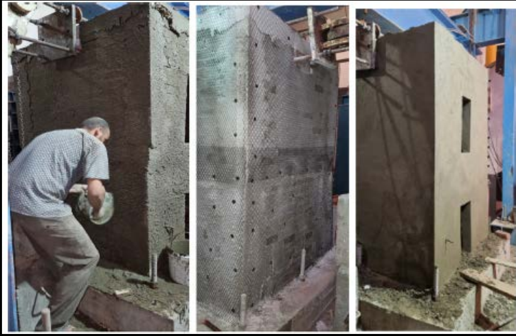
Şekil 7. Ferrocement ile Güçlendirme Aşamaları
