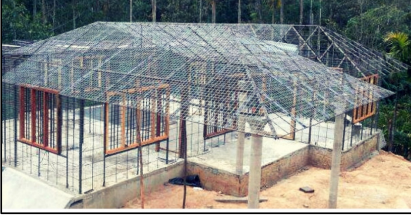
Şekil 3. İnşa Halindeki Ferrocement Ev
