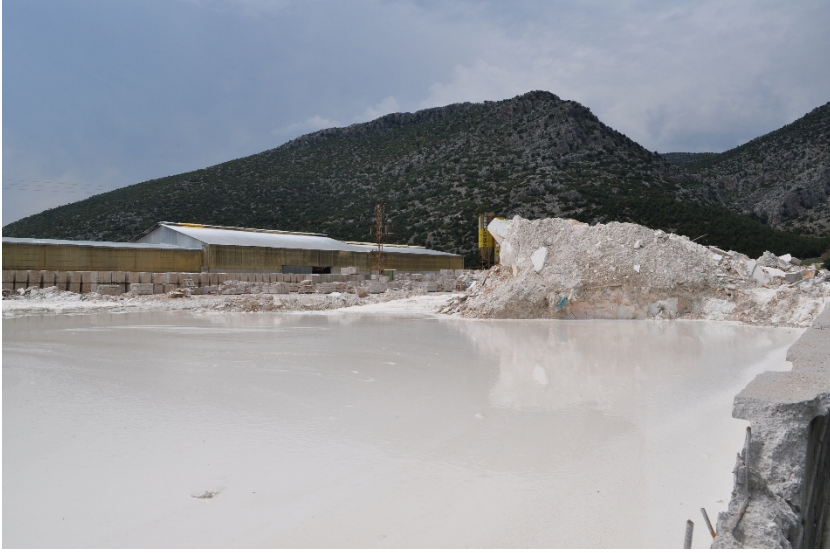
Şekil 5. Mermer fabrikası arıtma tesisi çevresinde biriken toz (çamur) artıklar
