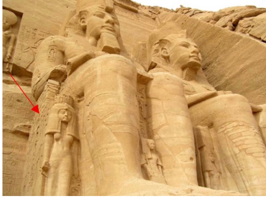
Resim 1. Antik Mısır’da Abu Simbel Tapınağı’ndaki II. Ramses heykelinin hasarlı kolunun taş bloklarla desteklenmesi (Smith, Tunmore, 2007, s.8)
