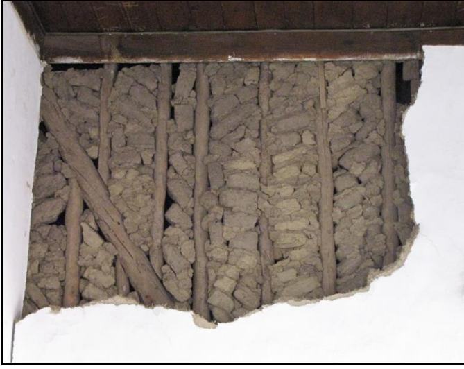
Şekil 9. 1K-01 Nolu Mekândan Duvar Strüktür Detayı
