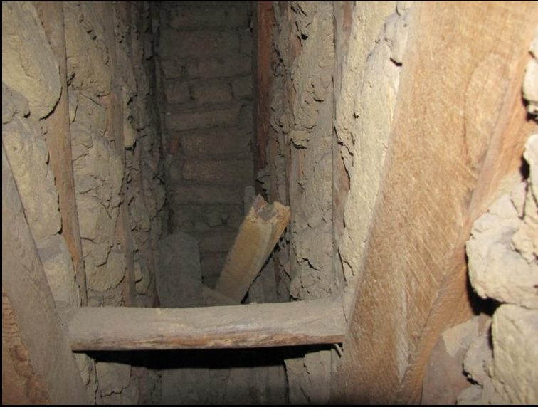
Şekil 7. Çift Cidarlı Duvarın İçeriden Görünümü
