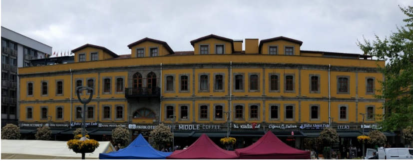
Görsel 5. TS Park Otel Güney Cephesi
