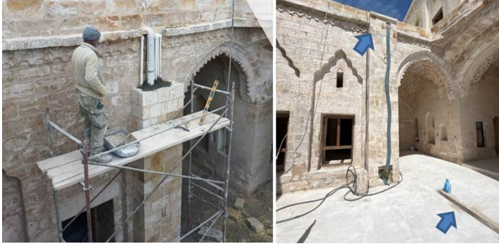
Şekil 4. Birinci kat avlusunda cepheye eklenen taş kaplı şaft.
