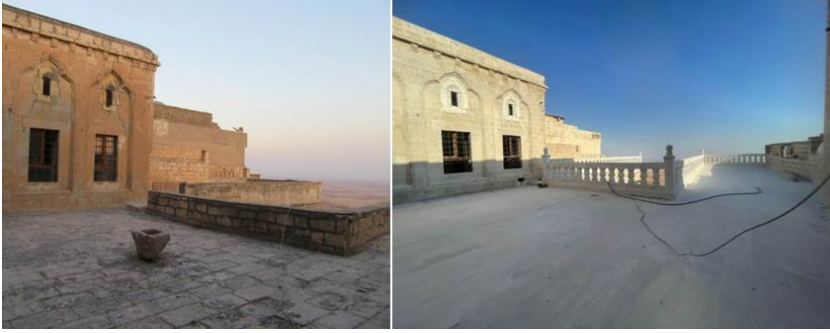
Şekil 6. İkinci kat avlusunun öncesi ve sonrası
