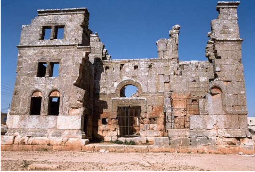
Şekil 7. Kalb Lozeh Kilisesi batı cephesi (URL-2)
