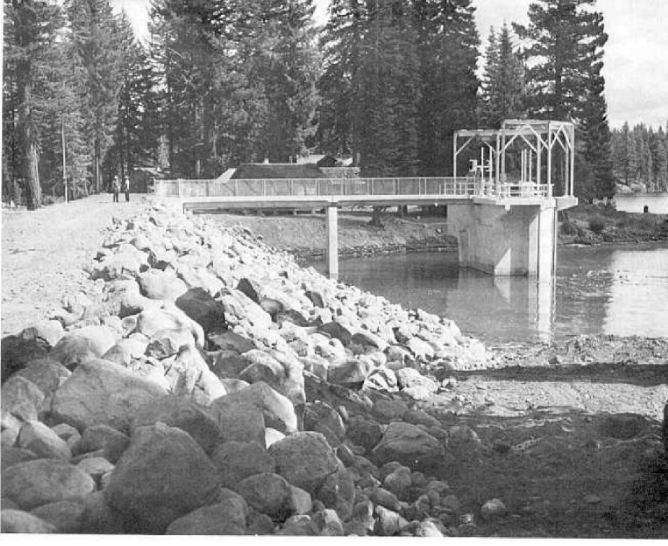
Şekil 4-1. Oregon’da Crescent Creek üzerinde yer alan ve küçük bir toprak dolgu depolama barajı olan Crescent Lake Barajı.
