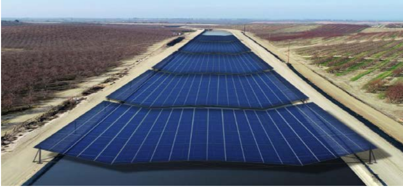
Fig. 4 Canal-top solar PV system ( Solar AquaGrid)
