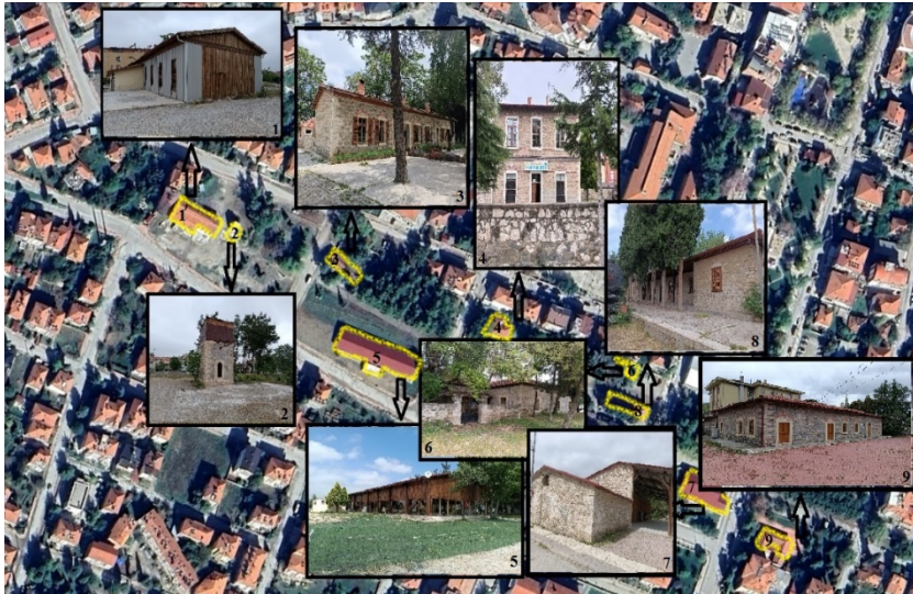
Şekil 4. Çivril Tren İstasyonu binalarının restorasyon çalışması sonrası fotoğrafları
