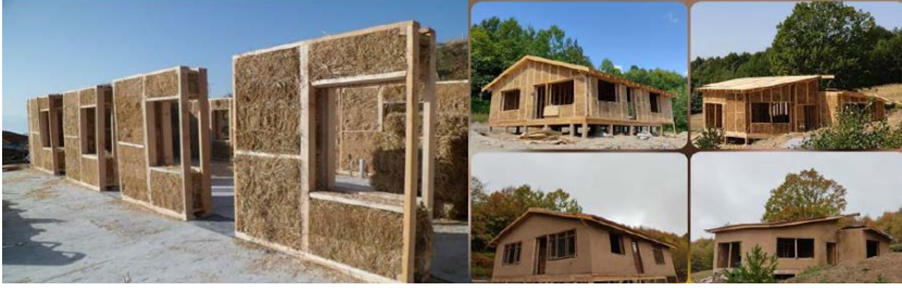
Şekil 5. Binalarda saman kullanımına dair uygulama örnekleri (Anlar, 2025).
