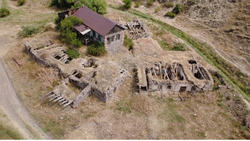
Şekil 1. Yerleşke genel görünüm (Şimşek Beyaz, 2025)
