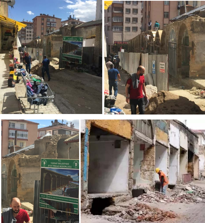
Şekil 6. Tol Çarşı Restorasyon Uygulaması (Yazar Arşivi; httpswww.milliyet.com.tr/yerel-haberler/yozyozgatin-tektarihi-carsisinde-calismalar-suruyor-12042823 )
