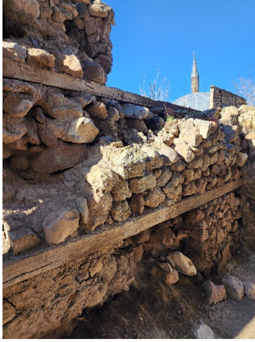
Şekil 3. Hatıllı yığma taş duvar detayı (Şimşek Beyaz, 2023).
