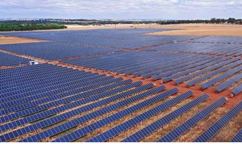
Şekil 5. Büyük ölçekli güneş enerjisi santrali ve panel yerleşim düzeni
