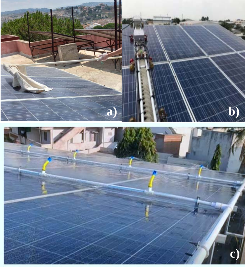
Şekil 2. (a) Manuel Temizlik, (b) Robotik Sistem ile Temizlik, (c) Su püskürtme ile Temizlik (Najmi & Rachid, 2023)
